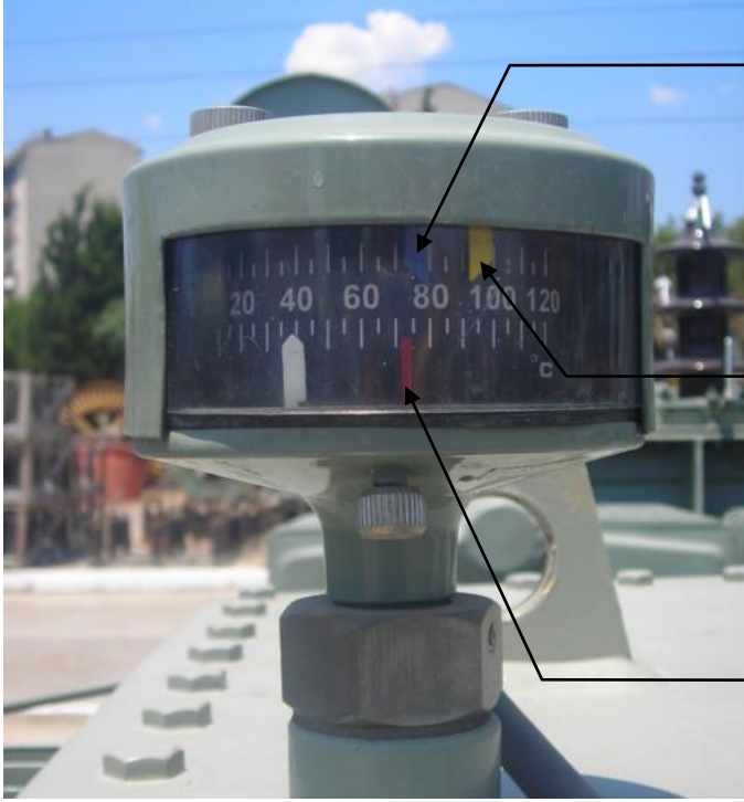
Şekil – 20 Çift Kontaklı Termometre
