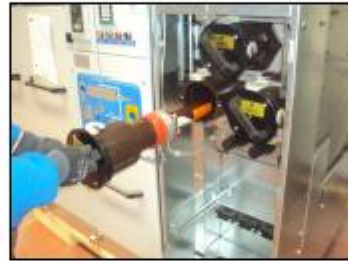
OG SİGORTAYI KOVANA YERLEŞTİRDİKTEN SONRA SİGORTA TAPASI YERİNE OTURACAK ŞEKİLDE KOVANI İÇERİSİNE YERLEŞTİRİN.
