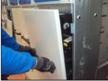
TOPRAKLAMA AYIRICISINI KAPATILARAK HÜCRE ÖN KAPAĞINI AÇINIZ.
