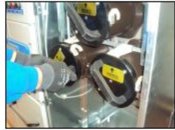
SİGORTA TAPASINI KOVANI İÇERİSİNE YERLEŞTİRDİKTEN SONRA SAĞA DOĞRU ÇEVİREREK KOVANI ÜZERİNDEKİ TIRNAKLARI KOVANI TÖPÜ ÜZERİNDEKİ YUVAYA TAKINIZ.
