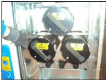
SİGORTA TAPASI ÜZERİNDEKİ PİMİN SİGORTA ATTIRMA DÜZENEGİ PLASTİK PARÇAYA OK İSTİKAMETİNDE GELECEK ŞEKİLDE KONTROLÜNÜ YAPINIZ.
