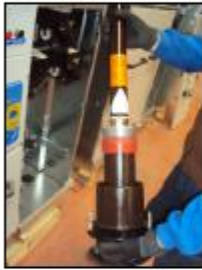
OG SİGORTANIN OK YÖNÜ SİGORTA TAPASI İÇERİSİNE GELECEK ŞEKİLDE MONTE EDİNİZ. KELEPÇESİNİN SIKI OLDUĞUNDAN EMİN OLUNUZ.
