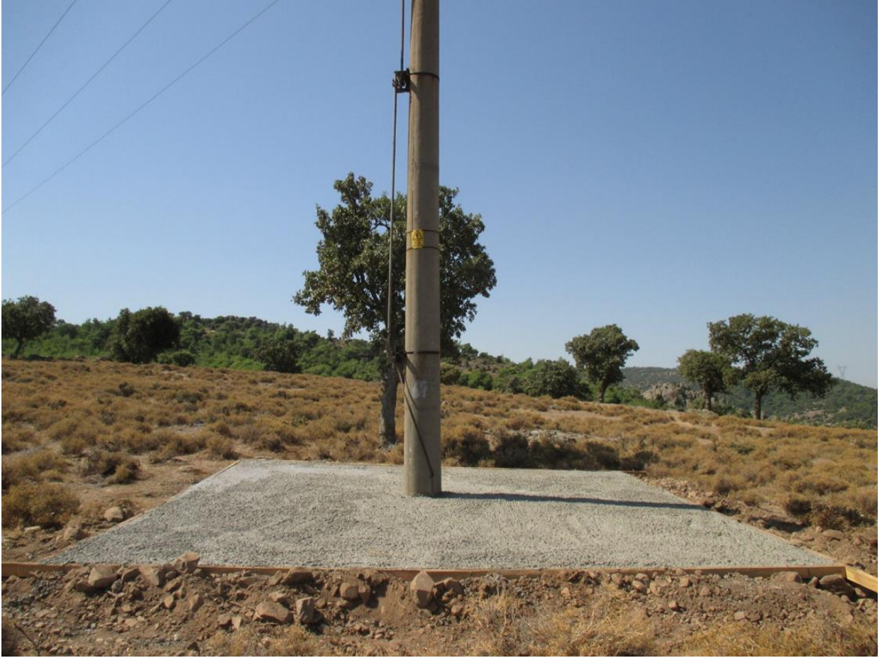
Ark ve yangın önleyici Ayırıcı direği alt bölümünün betonu.
